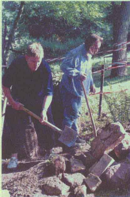
Bau einer Sandsteinmauer...
